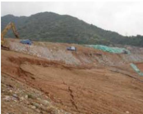
图4 深圳某填埋场堆体失稳滑移
