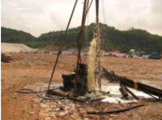
图7 填埋场钻孔作业过程中的水气喷涌
