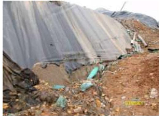
图 29 陡坡上土工织物和土工膜的拉伸破坏
