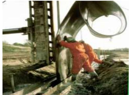
图 23 HDPE 膜-膨润土复合防渗墙的施工照片
